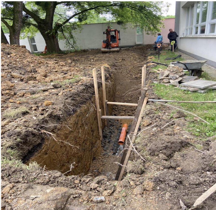
Oprava havárie kanalizace
